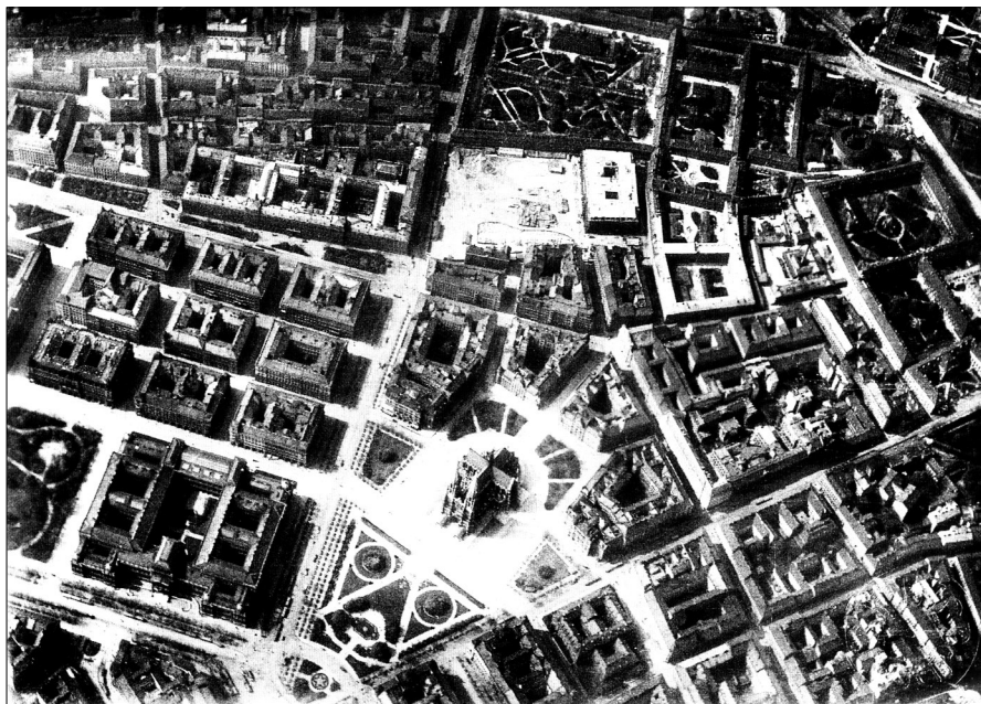
Luftaufnahme Votivkirchen-Viertel mit unfertiger Nationalbank
